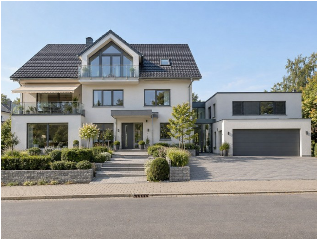
Bild 1 - Außenansicht, Ansicht Straßenseite, Garage
