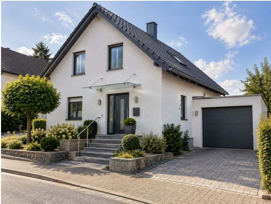
Bild 1 - Außenansicht, Ansicht Straßenseite, Garage
